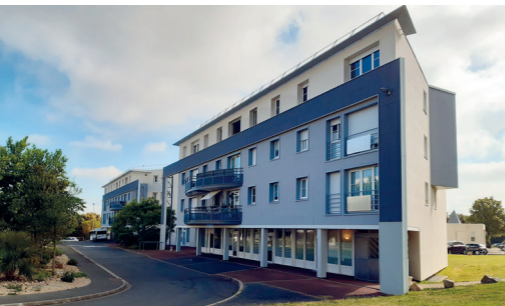
Ravalement de façade Le Platin - Les Minimes
